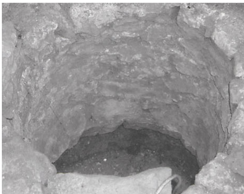
Biedesheimer Schacht (Foto: Wasem, S. 131)
