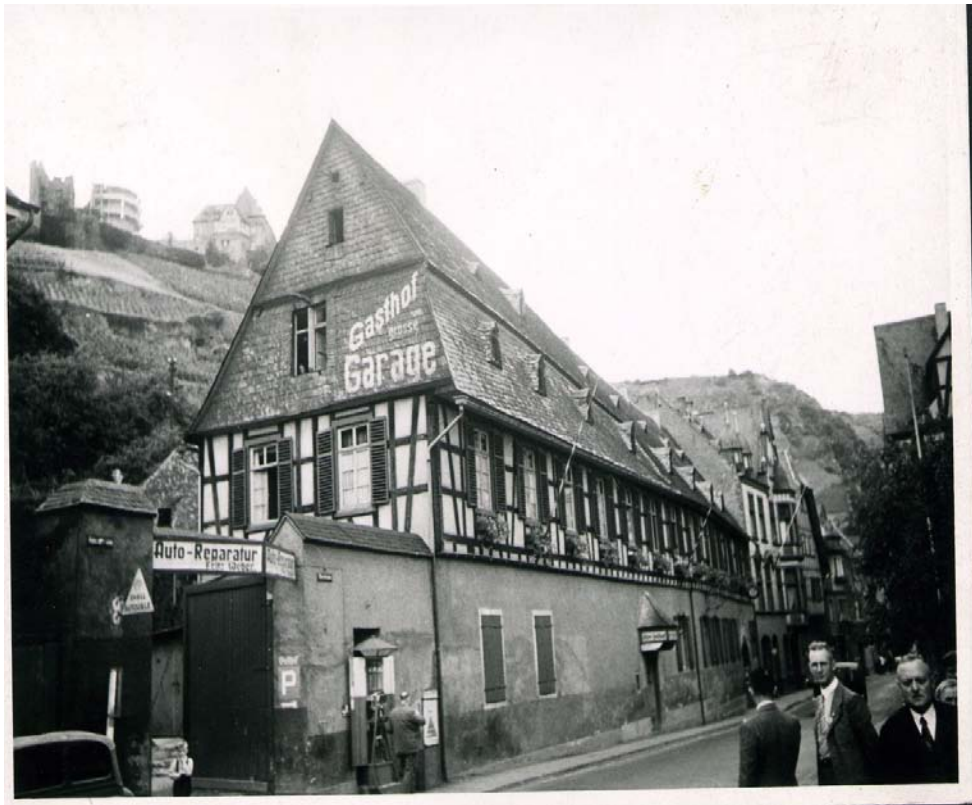
Blick von Süden auf das Gebäude, oben sieht man die im Wiederaufbau befindliche Burg (Foto: Archiv Geschichtsverein)
