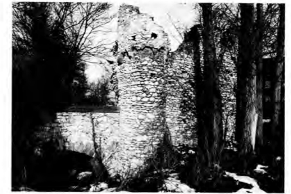
Abb. 3 Elsheim, sogen. Elftausendmädgeturm. Rest der Straßensperre
