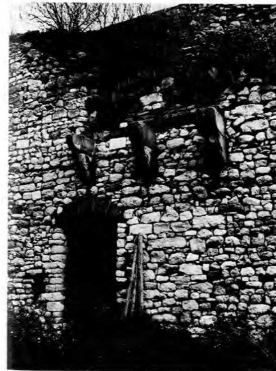
Abb. 2 Burg Stadecken. Reste der Hauptburg mit Kragkonsolen
