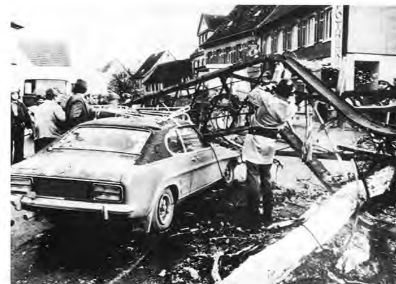
Technische Hilfe: Einsatz von Trennschleifern zur Beseitigung eines umgestürzten Kranes
