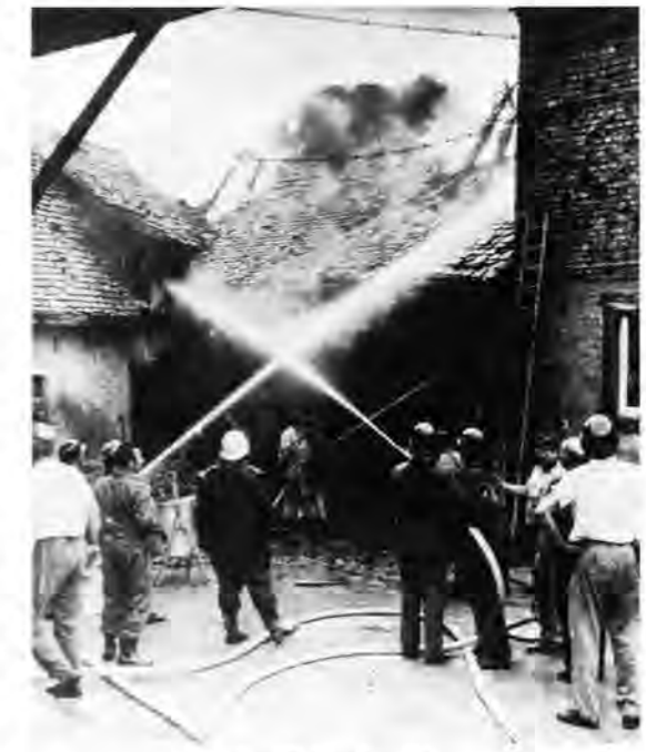
Brandbekämpfung (1): C-Strahlrohre im Löscheinsatz bei einem Scheunenbrand
