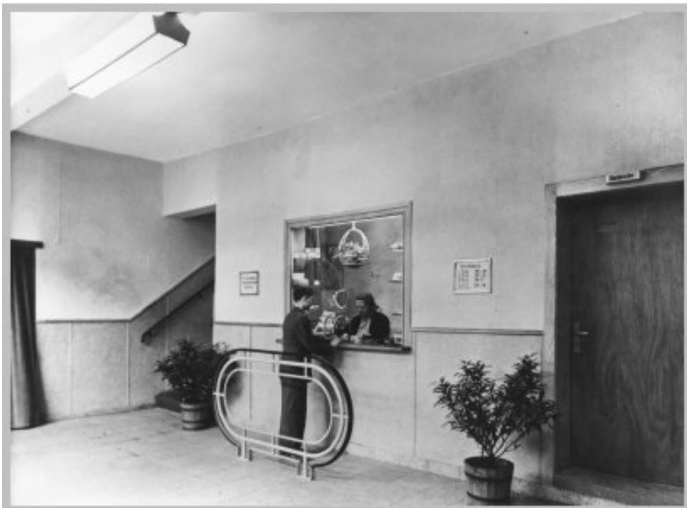
Foyer mit Kasse, links der Aufgang zum Kinosaal.
