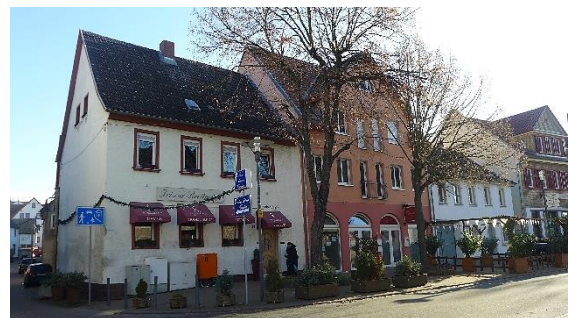
2020, links ehem. Bäckerei Frisch, Pariser Straße Nr. 94. Früher Gasthaus Zum Schwanen, dann Zum fröhlichen Mann, dann Zur Crone. 25
