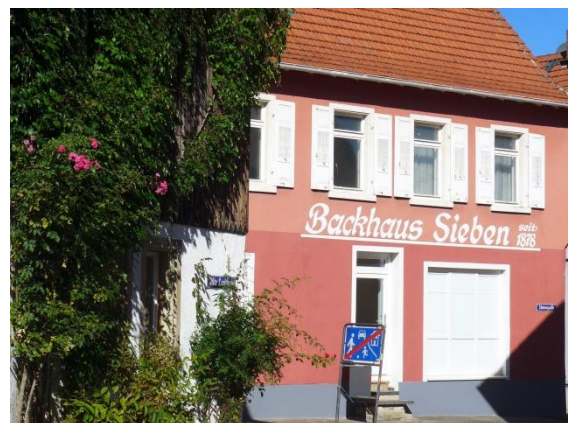
Ehemalige Bäckerei Seibert, später Volz und Sieben, Untergasse Nr. 37. 11
