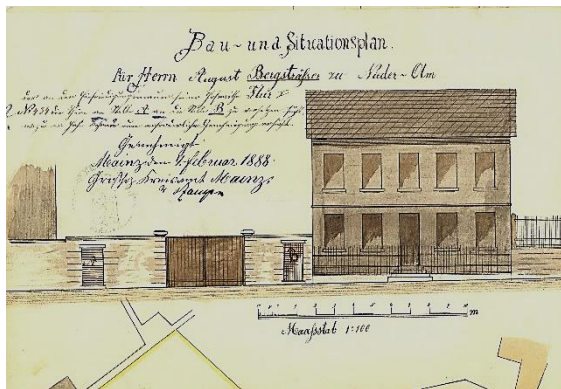
1888, Haus Bergsträßer, Pariser Straße 127. 2
