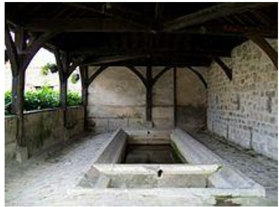
Beispiel einer Waschhalle. 4
