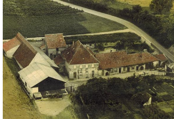
Wingertsmühle, Luftaufnahme aus den 1950er Jahren. 8
