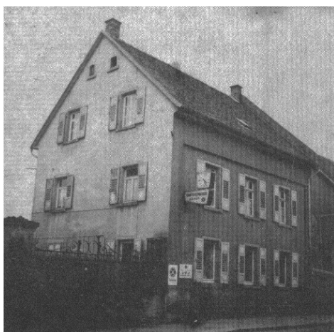
1967, Raiffeisengenossenschaft, Oppenheimer Straße Nr. 13.
