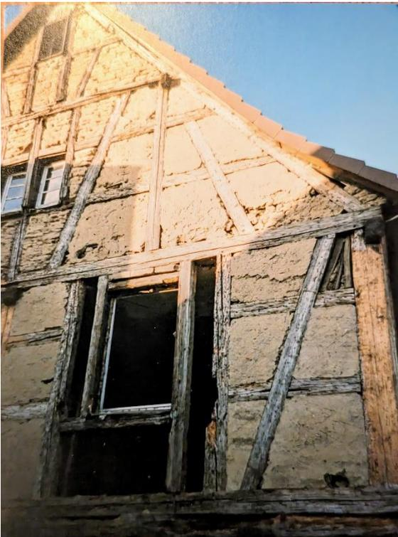
Bauzustand nach Freilegung des Fachwerks.<sup>24</sup>
