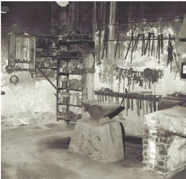
1985, nach den ersten Ausräumungsarbeiten
