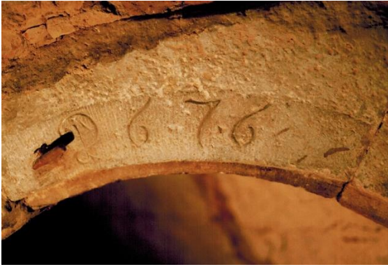
1676, Inschrift im Sandsteingewände an der Kellertreppe. 33
