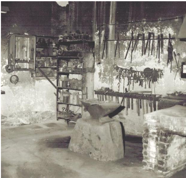
1985, nach den ersten Ausräumungsarbeiten
