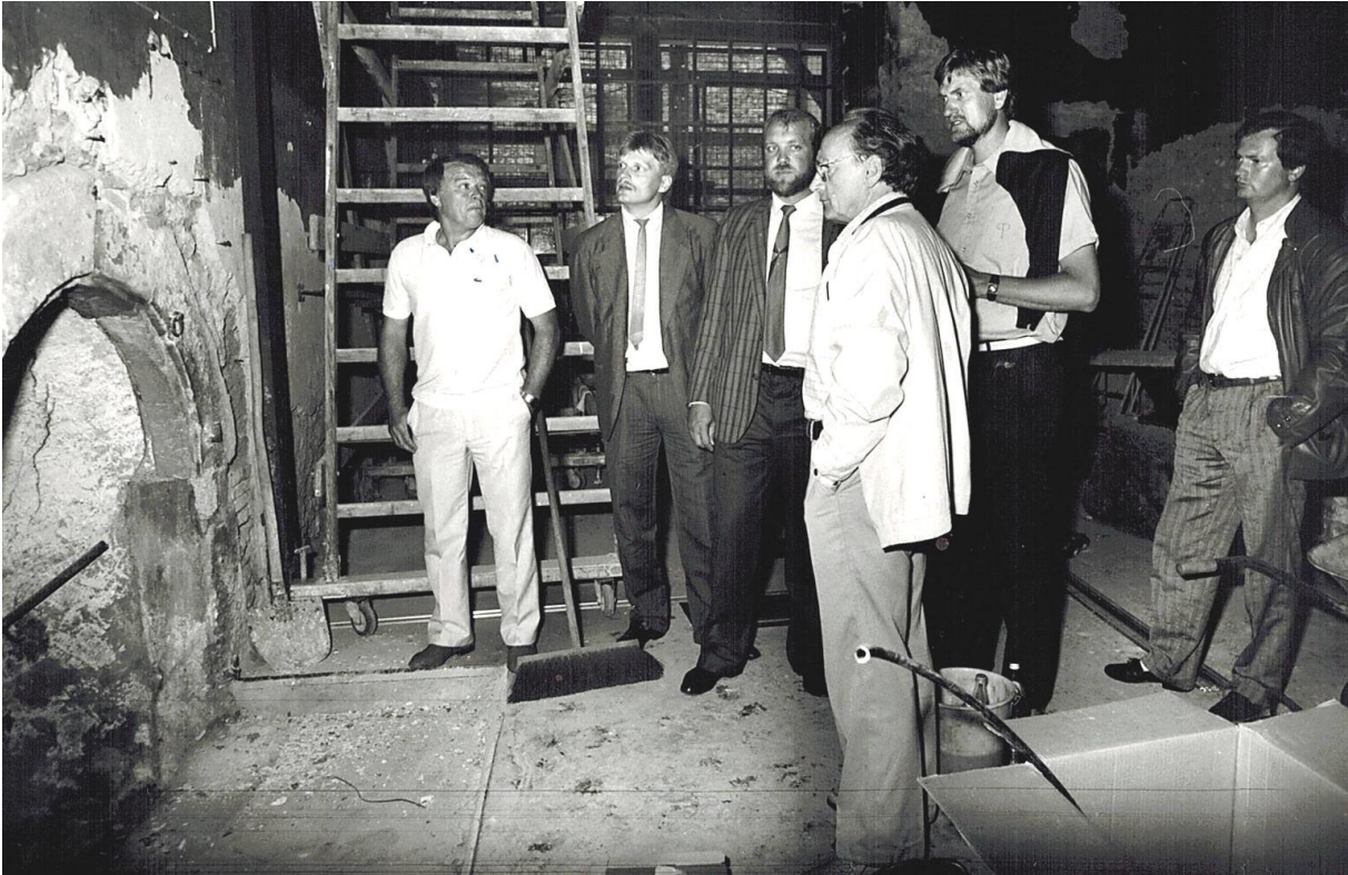
1986, Besichtigung durch das Amt für Denkmalschutz. Von links: Willi Beißmann (gen. Zick), NN, Bürgermeister Hartmut Schäfer, Hr. Kahl (Denkmalamt), Peter Weisrock, Hr. Bachtler, Sanierungsbüro.
