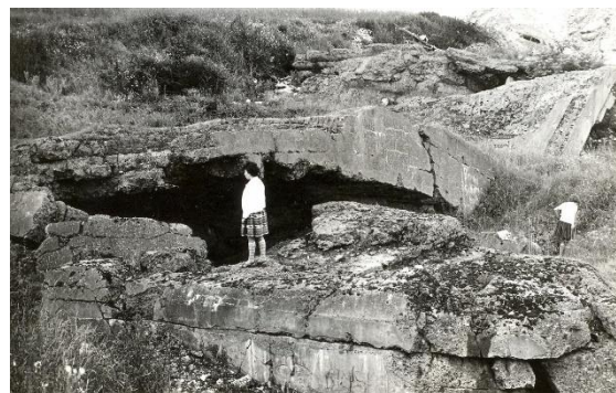
1960, die noch sichtbaren Reste des gesprengten Fort Muhl. 3
