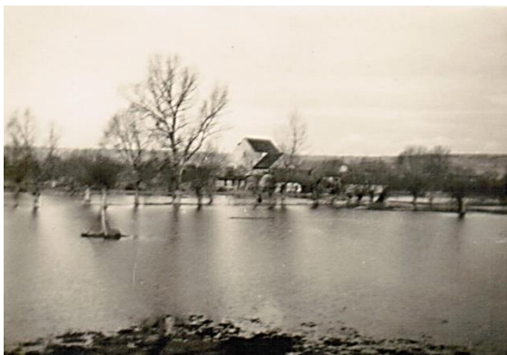
1941, Selzüberschwemmung an der Wiesenmühle, Nieder-Olm. 1
