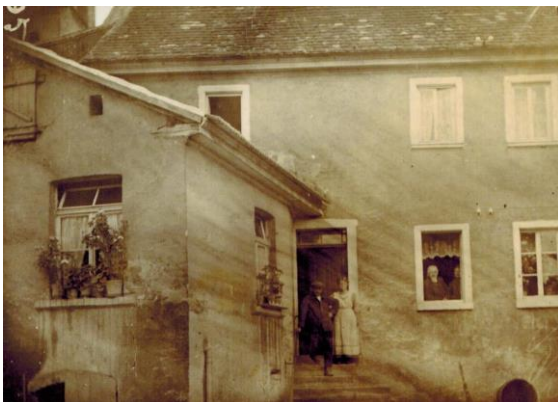
Backhausstraße Nr. 8. Elternhaus von Jakob Sieben I. Ehem. mittelalterlichen Präsenzhof des Domkapitels, ab 1802 Conrad Sieben I., Landwirt, Ölmüller und Bürgermeister. Durch Bombenangriff 1945 völlig zerstört. 2
