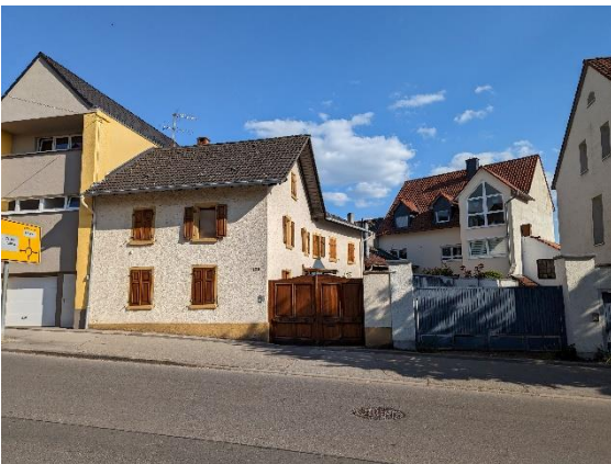
2023, das Anwesen des ehemaligen Bullenstalls, Pariser Straße Nr. 128. Der hintere Teil mit dem ehemaligen Stallgebäude wurde neu bebaut. 37
