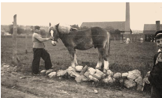
1950er Jahre, die letzte Vieh- und Pferdeweide, heutiges Sportplatzgelände. Im Hintergrund die Weinbrennerei der Firma Eckes. 53
