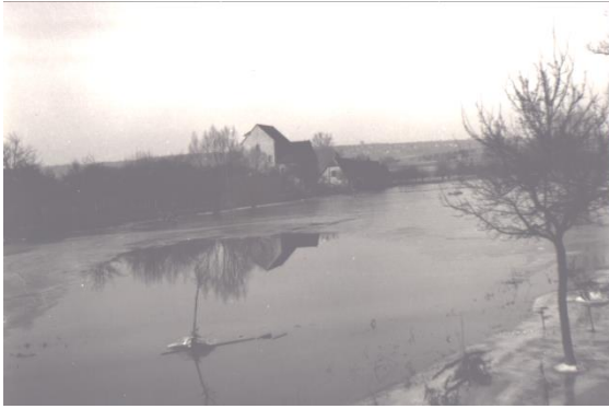
1930er Jahre, Hochwasser an der Wiesenmühle. 42
