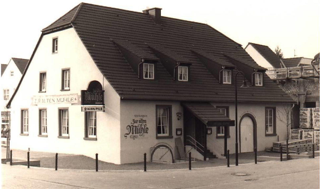
1989, Woogmühle nach der Sanierung. 40
