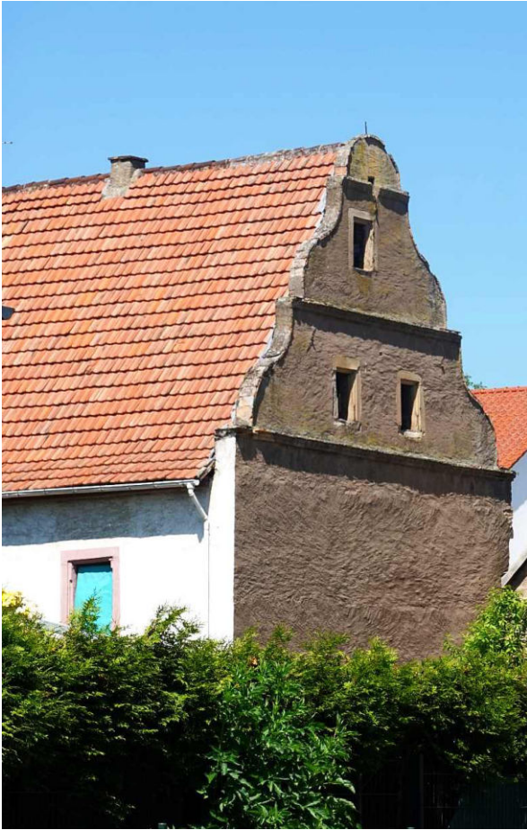
Abbildung 4.1: Schloss von Dienheim, dessen Grundstein im Jahr 1588 gelegt wurde (Aufnahme 2024). Der Ostteil des Gebäudes mit seiner Renaissance-Fassade und dem geschwungenen Giebel könnte eine Auffrischung gebrauchen.
