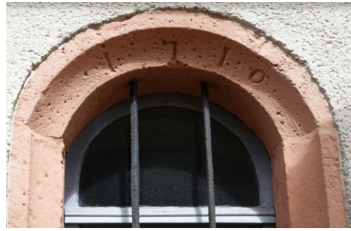
Abbildung 5.3: Fenster im romanischen Chor der St. Andreas-Kirche in Klein-Winternheim, ursprünglich aus dem 10. - 11. Jahrhundert. In den Jahren 1710 - 1711 wurde die Kirche auf Kosten der Gemeinde von Grund auf erneuert.
