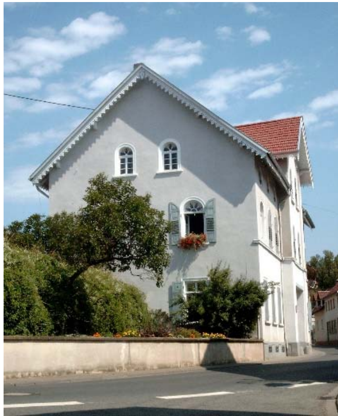
Abb. 6: Wohn- und Werkstattgebäude erbaut (Windesheimer Str. 8)
